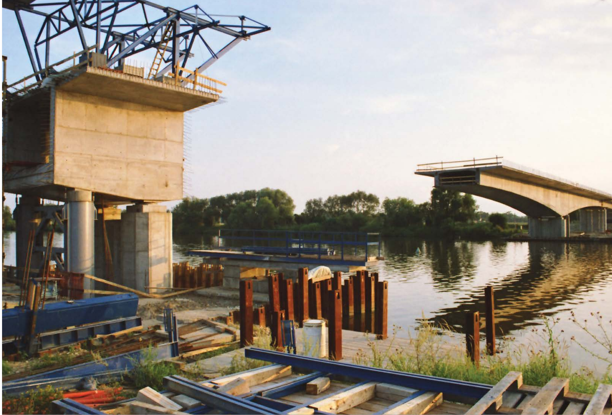
Opole, budowa mostu na obwodnicy, ok. 2000
