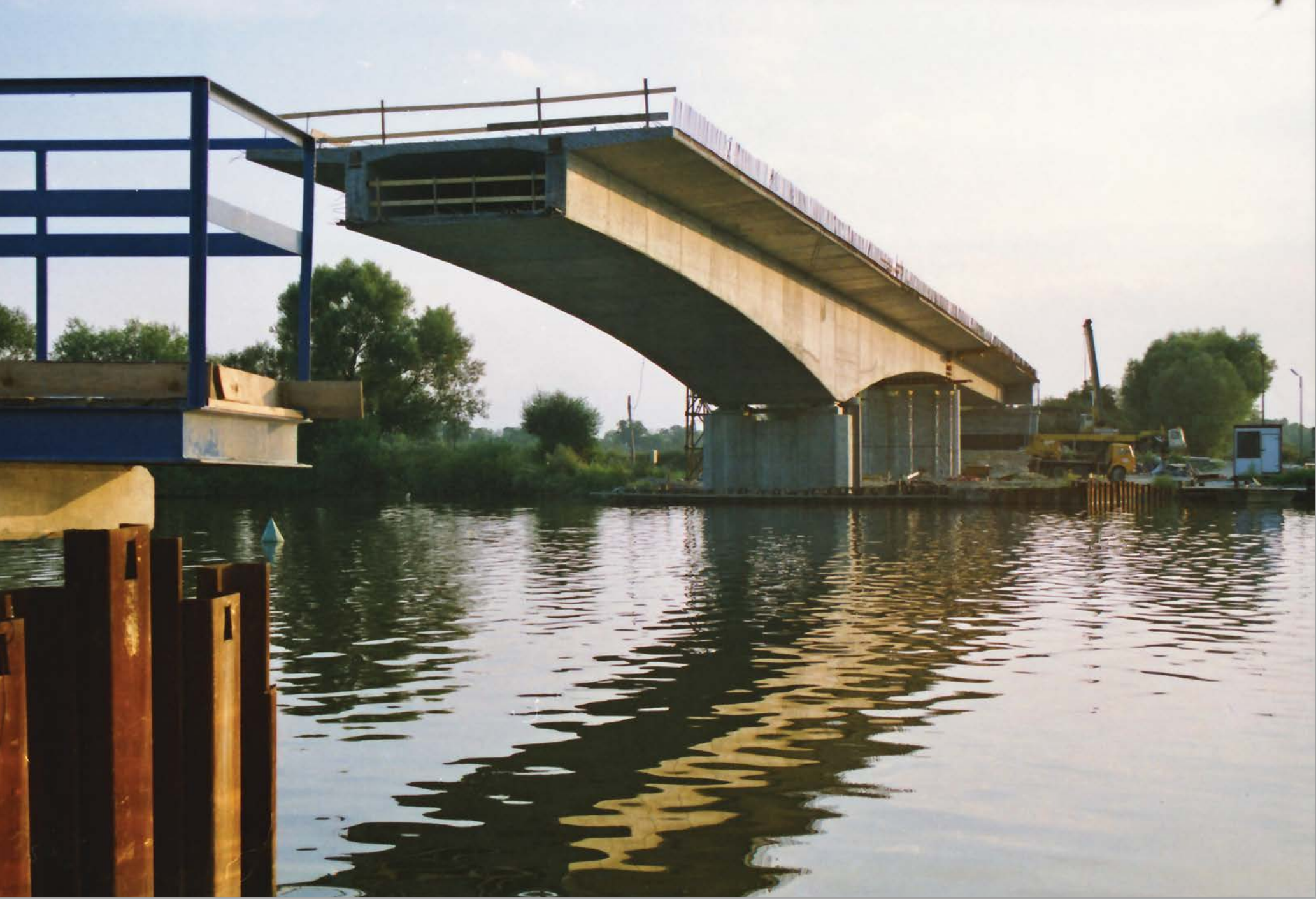
Opole, budowa mostu na obwodnicy, ok. 2000
