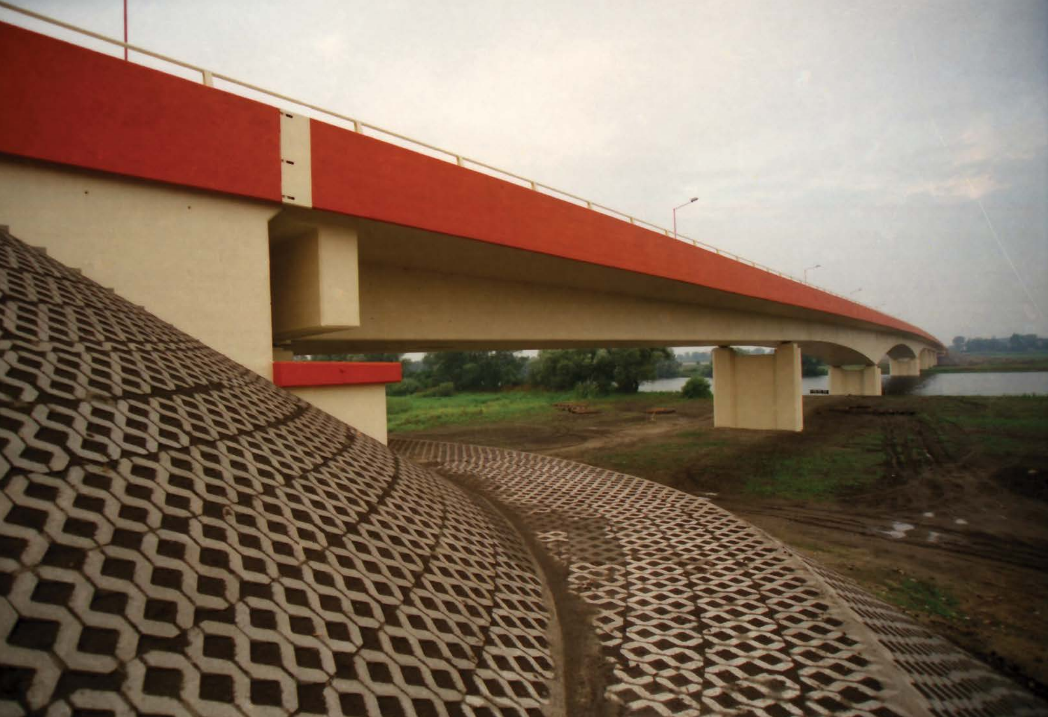
Opole, budowa mostu na obwodnicy, ok. 2000
