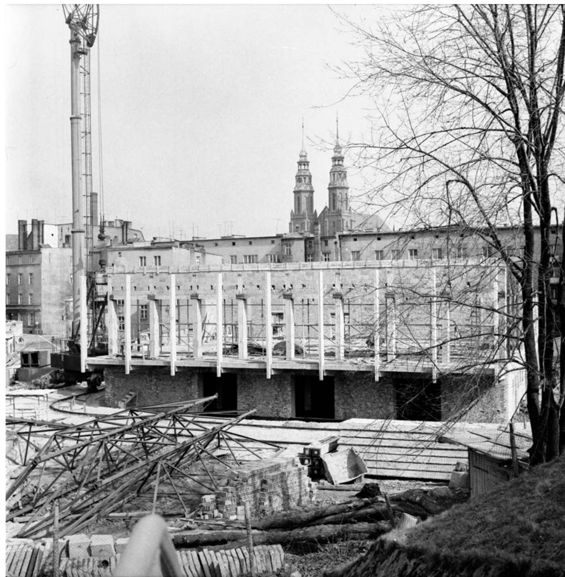
Opole, budowa stołówki Urzędu Wojewódzkiego, lata 70
