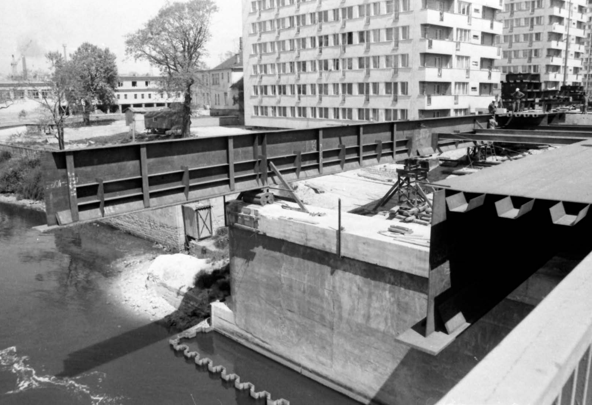
Opole, budowa mostu Sybiraków, lata 60./70.
