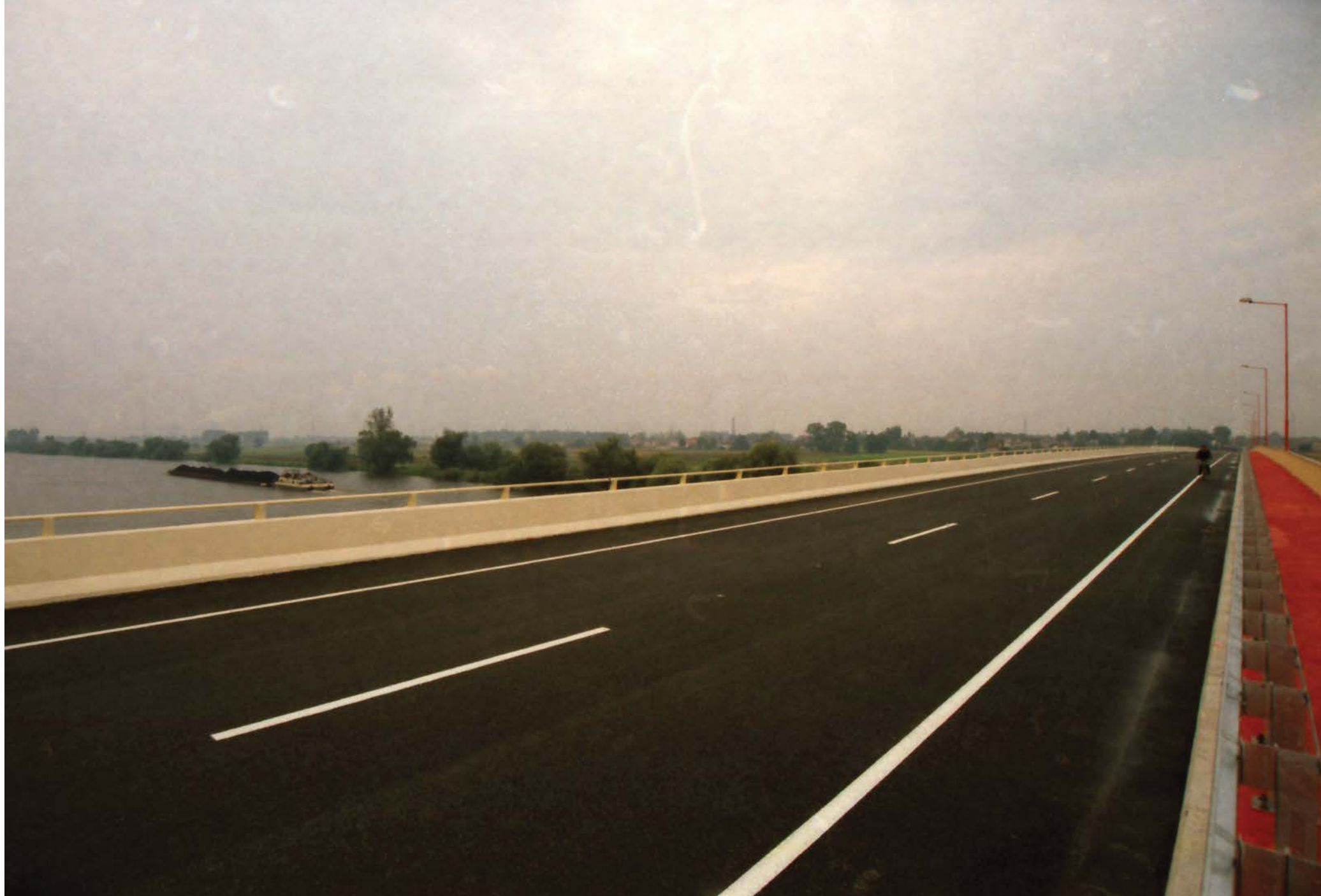
Opole, budowa mostu na obwodnicy, ok. 2000
