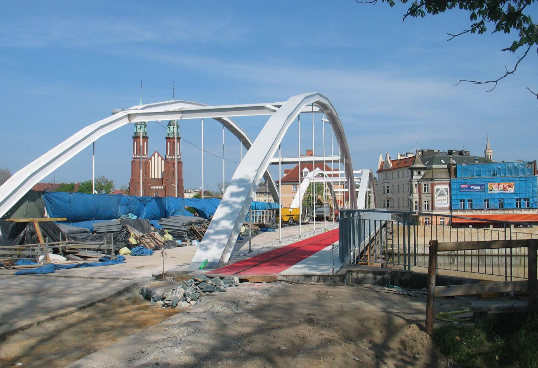
Opole, remont Mostu Piastowskiego, 2005
