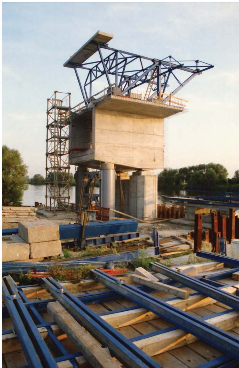
Opole, budowa mostu na obwodnicy, ok. 2000
