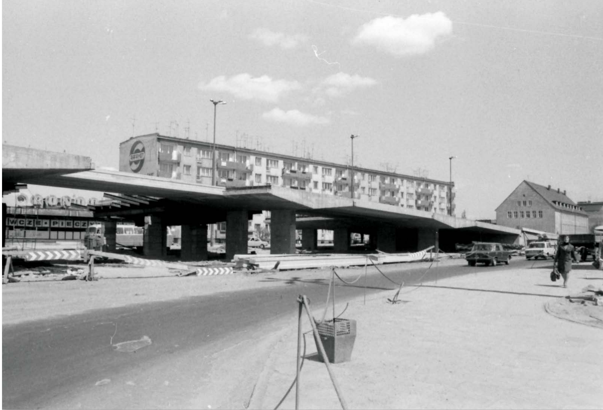
Opole, budowa estakady przy moście Sybiraków, lata 60/70.
