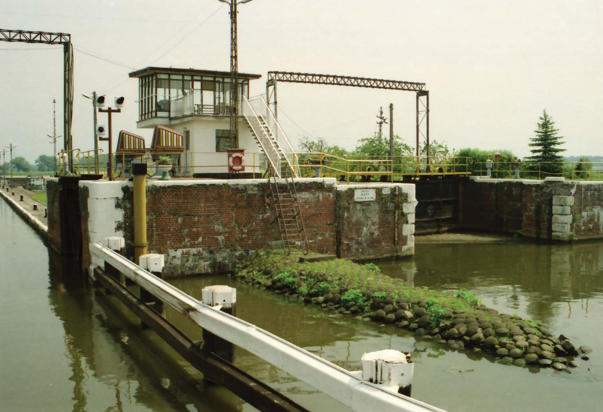
Sluza, Odra, odcinek Rogów-Opole, 2000
