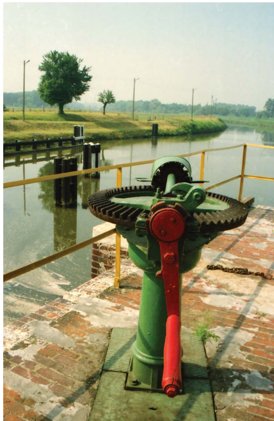
Odra, odcinek Rogów-Opole, 2000
