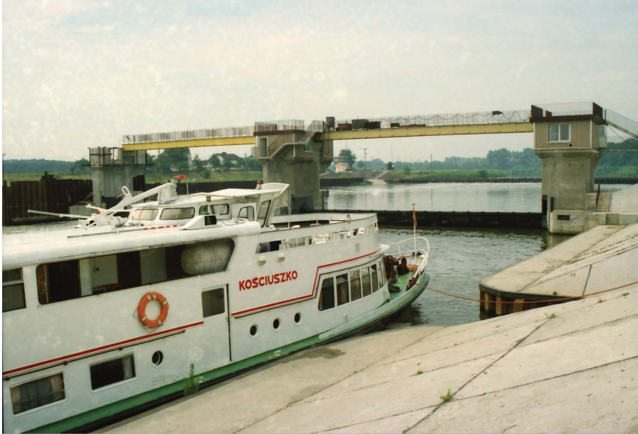
Odra, odcinek Rogów-Opole, 2000
