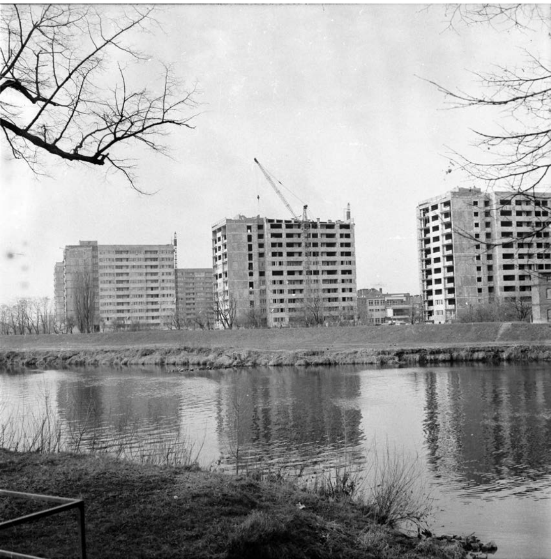
Opole, budowa osiedla na ul. Spychalskiego, lata 70
