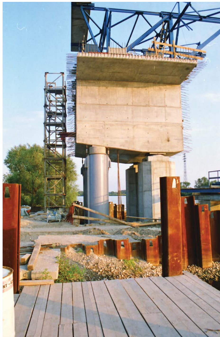
Opole, budowa mostu na obwodnicy, ok. 2000
