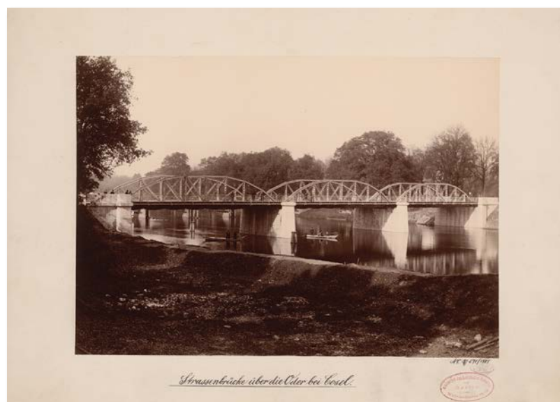
Fot. 16. Koźle. Most na Odrze, ok. 1885 r., fot. Ph. Platz, Racibórz, Zbiory TU Architekturmuseum Berlin, Nr inw. BZ-F 09,023
