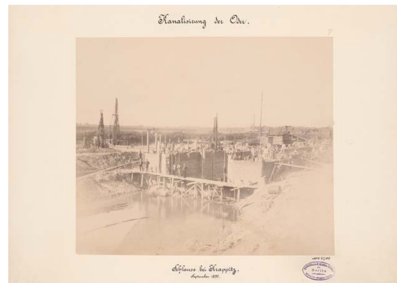
Fot. 9. Krapkowice. Budowa śluzy, wrzesień 1893 r., fot. Gebr. Katzbach, Opole, Zbiory TU Architekturmuseum Berlin, Nr inw. BZ-F 15,007
