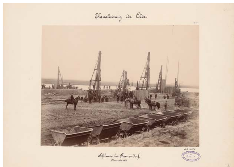
Fot. 12. Wróblin. Budowa śluzy, listopad 1893 r., f ot. Gebr. Katzbach, Opole, Zbiory TU Architekturmuseum Berlin, Nr inw. BZ-F 15,012
