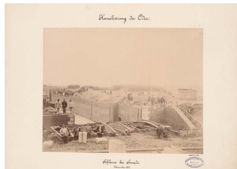
Fot. 14. Zawada. Budowa śluzy, listopad 1893 r., fot. Gebr. Katzbach, Opole, Zbiory TU Architekturmuseum Berlin, Nr inw. BZ-F 15,013
