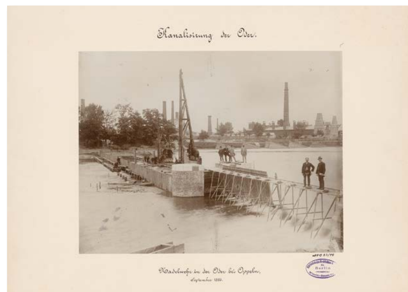
Fot. 6. Opole. Budowa jazu koźłowo-iglicowego, wrzesień 1893 r., fot. Gebr. Katzbach, Opole, Zbiory TU Architekturmuseum Berlin, Nr inw. BZ-F 15,005
