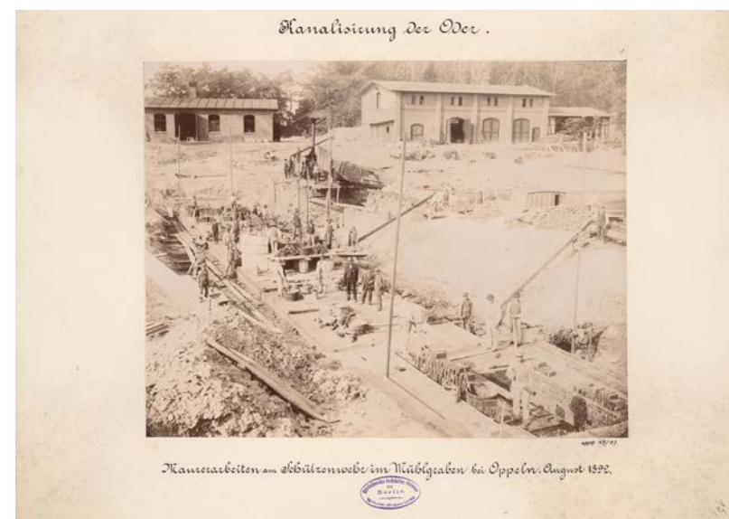
Fot. 2. Opole. Prace murarskie przy budowie jazu na Młynówce, sierpień 1892 r., fot. NN, Zbiory TU Architekturmuseum Berlin, Nr inw. BZ-F 15,001
