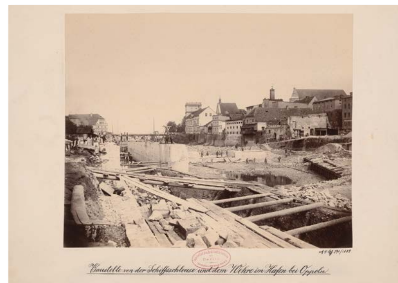
Fot. 1. Opole. Budowa śluzy żeglujowej i jazu na Młynówce, ok. 1880-1886 r., fot. NN, Zbiory TU Architekturmuseum Berlin, Nr inw. BZ-F 09,022
