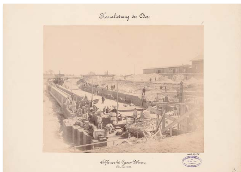
Fot. 8. Dobrzeń Wielki. Budowa śluzy, październik 1893 r., fot. Gebr. Katzbach, Opole, Zbiory TU Architekturmuseum Berlin, Nr inw. BZ-F 15,008
