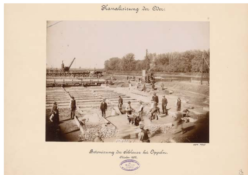
Fot. 4. Opole. Prace betoniarskie podczas budowy śluzy, październik 1892 r., fot. NN, Zbiory TU Architekturmuseum Berlin, Nr inw. BZ-F 15,004
