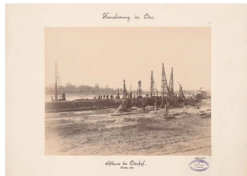
Fot. 10. Kąty. Budowa śluzy, październik 1893 r., fot. Gebr. Katzbach, Opole, Zbiory TU Architekturmuseum Berlin, Nr inw. BZ-F 15,009
