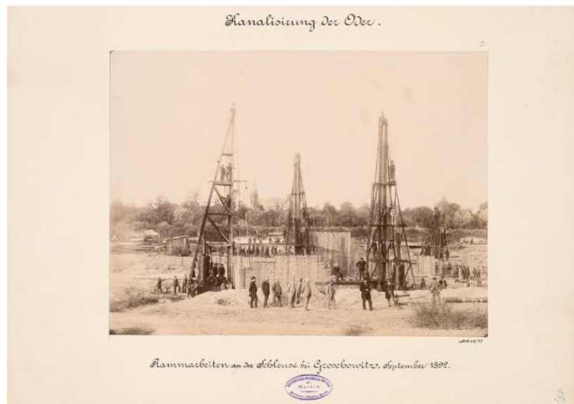
Fot. 3. Groszowice. Palowanie pod budowę śluzy, wrzesień 1892 r., fot. NN, Zbiory TU Architekturmuseum Berlin, Nr inw. BZ-F 15,002
