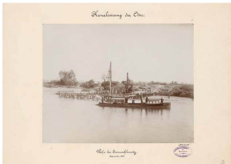
Fot. 7. Januszkowice. Budowa jazu, wrzesień 1893 r., fot. Gebr. Katzbach, Opole, Zbiory TU Architekturmuseum Berlin, Nr inw. BZ-F 15,006
